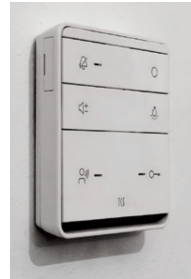
Foto 5: Gegensprechstellen, die oft in falscher Höhe montiert sind, schlecht erkennbare Symbole haben und eine Logik nutzen, mit der viele Menschen nicht zurechtkommen, findet man immer häufiger
